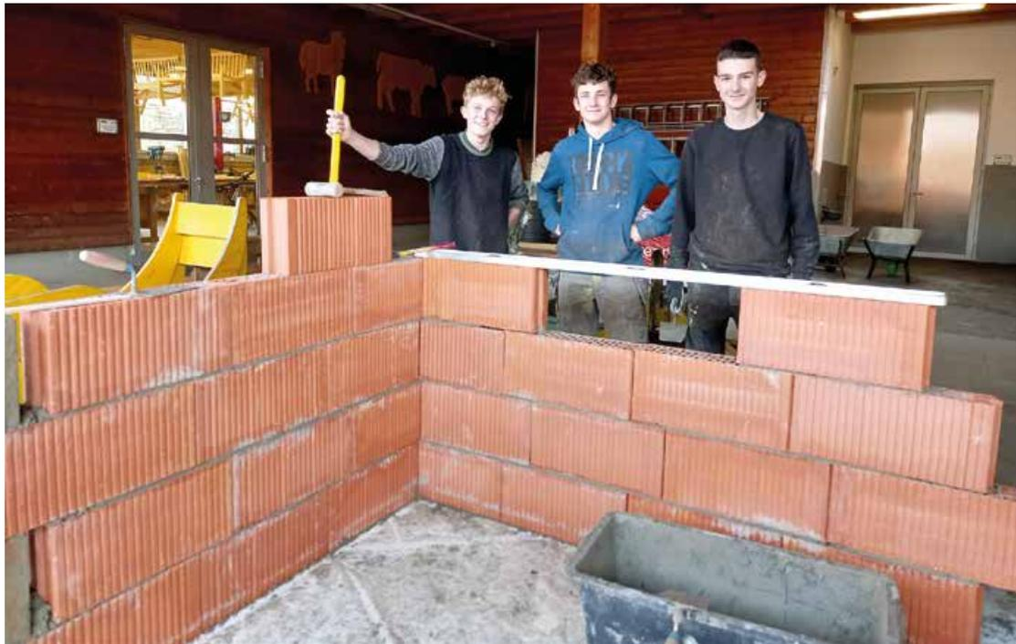
*Mit Hohlblockziegeln werden Wände mit Fenster und Türen aufgestellt!*
